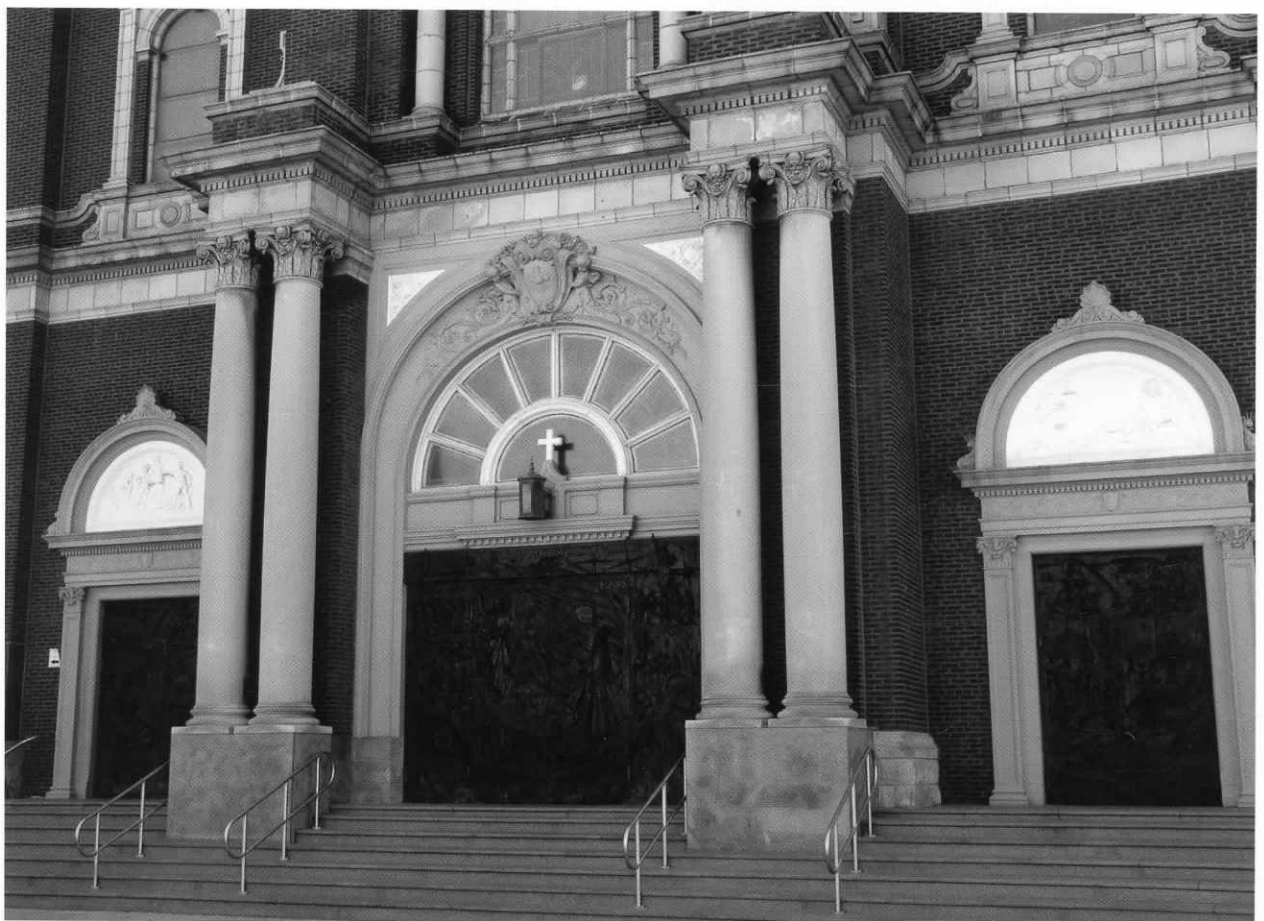
Main entrance doors – Wejście główne, na zdjęciu widoczne drzwi ze spiżu
